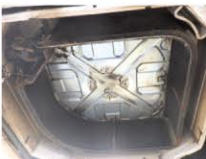
ほこりが積もって真っ黒なエアコン内部が分解洗浄でピカピカに！
